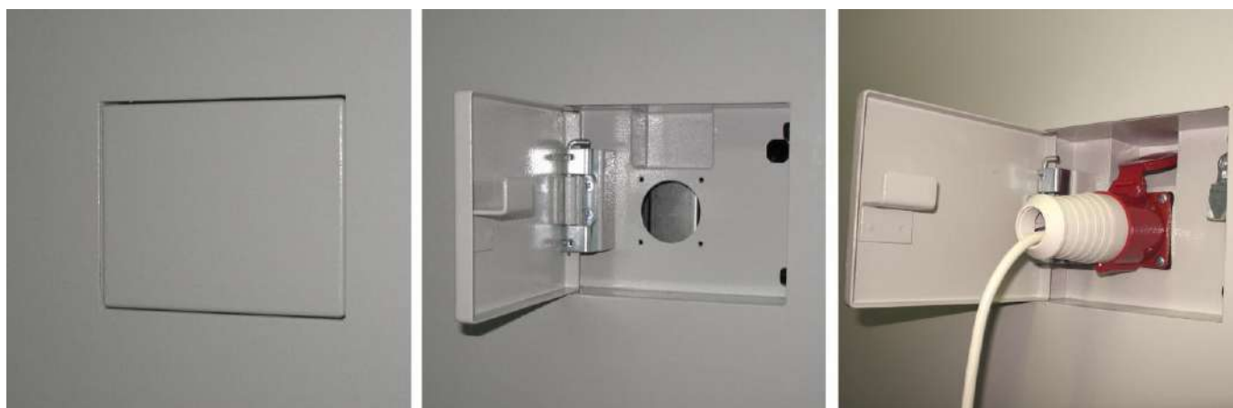
Отсек с вилкой для подключения ДГУ
